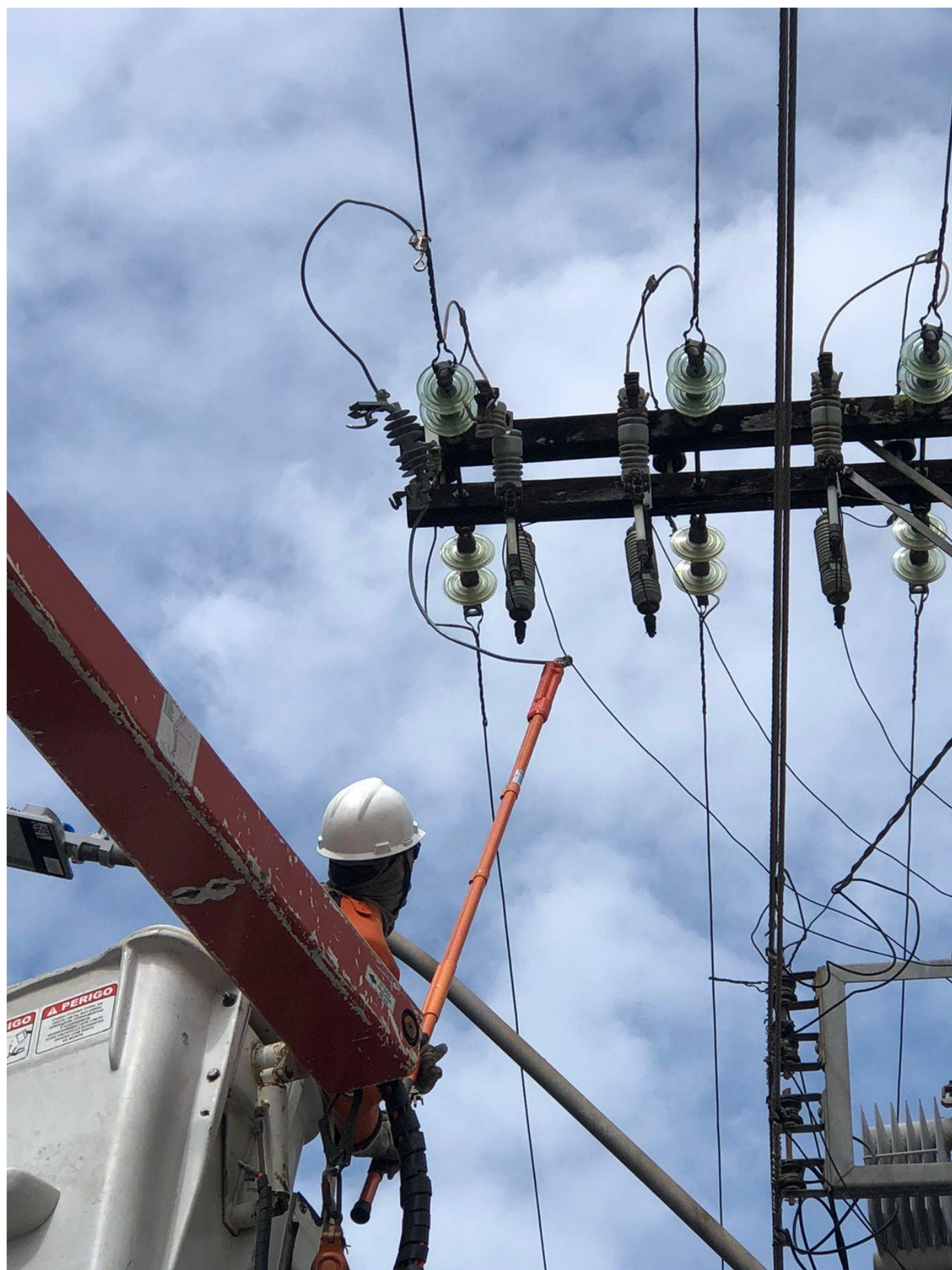
Figura 13 - Equipe realizando a instalação do suporte em emergência onde não tinha equipe de linha viva para ir até o local
