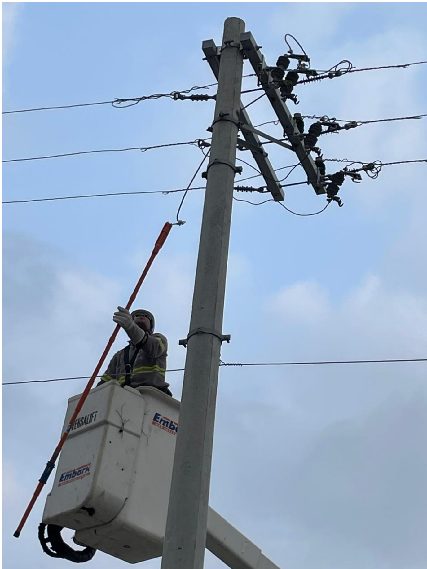
Figura 9 - Teste em centro de treinamento com jumper entre a mão francesa
