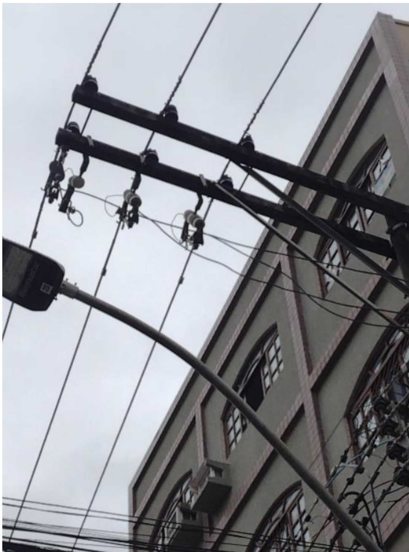
Figura 12 - Utilização de suporte de base fusível em situação de emergência
